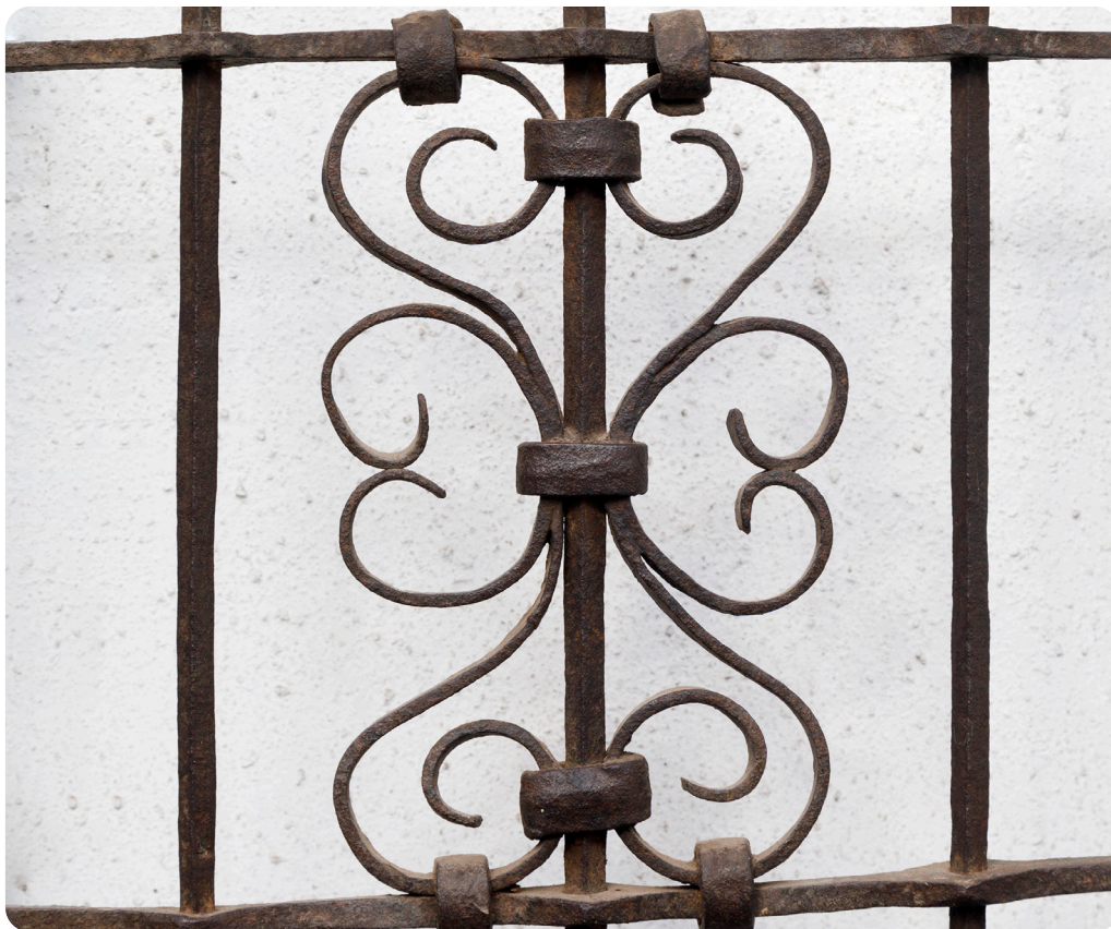
Detalle Reja de Ventana. MHSF ES009.
